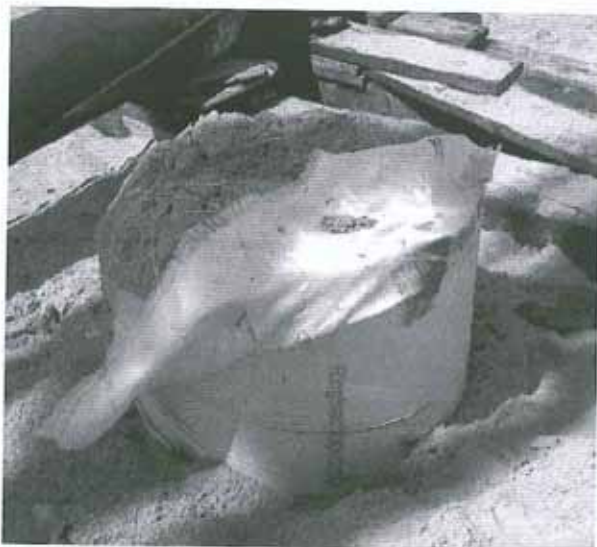
Bild 11. Geokunststoffummantelte Säule (GEC) mit RINGTRAC R 100/250
