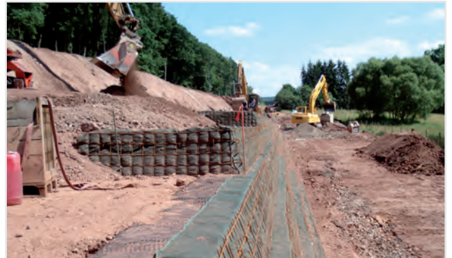
Figure 4: Grille HaTe® 23.142/GR utilisée comme protection contre l'érosion
