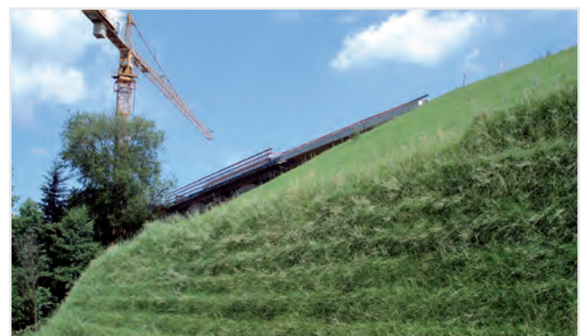
Figure 11: Ouvrage de soutènement – Solution Fortrac® Nature S – végétalisé.
