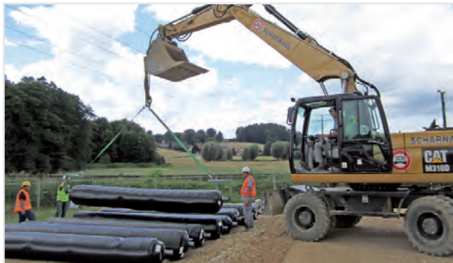
Figure 6: Stockage des rouleaux sur le chantier et utilisation du système de levage et de manutention
