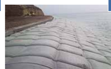
Remplissage des panneaux avec un béton fluide
