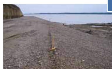
Préparation du fond de forme
