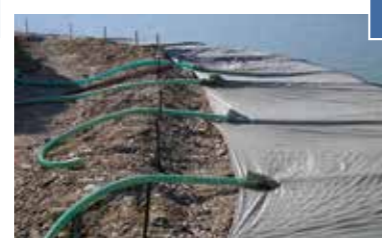
Mise en place des panneaux
