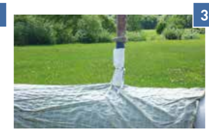
Remplissage du béton par une cheminée de remplissage
