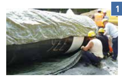
Mise en œuvre du panneau autour de la canalisation
