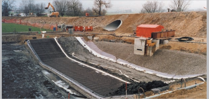
Bassin de rétention - étanchéité avec NaBento®
