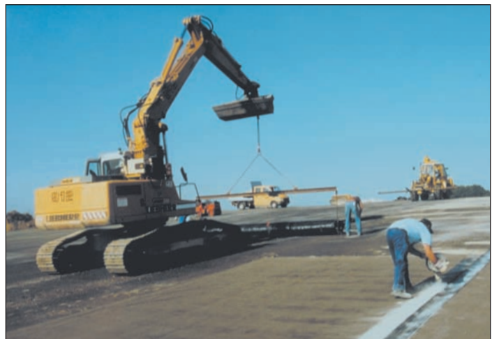
Installation en couverture de CSD (Centre de Stockage de Déchets)
