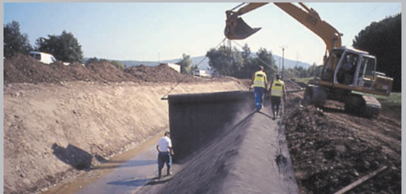
Etanchéité de berges et de lits de rivières avec NaBento®
