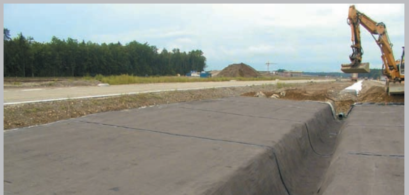
Etanchéité pour la protection de la nappe phréatique avec NaBento®
