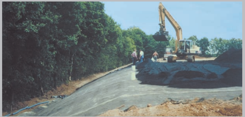
Couverture de décharge réalisée avec NaBento®
