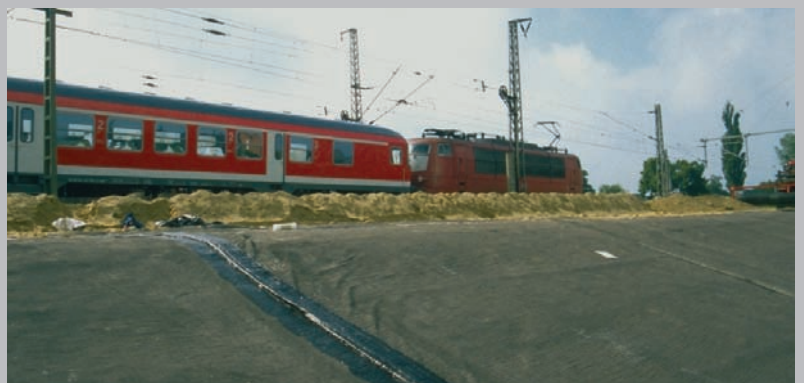
Etanchéité de digues avec NaBento®
