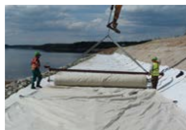
Mise en place des tubes (par exemple, avec notre aide à la pose)
