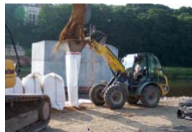
Remplissage mécanique au moyen d'une trémie et d'une excavatrice
