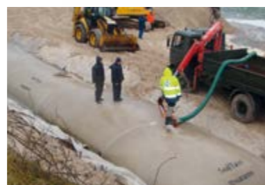
Remplissage des tubes (drague aspiratrice, pompe submersible de dragage)
