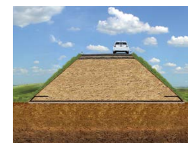
Remblais sur sol mou
