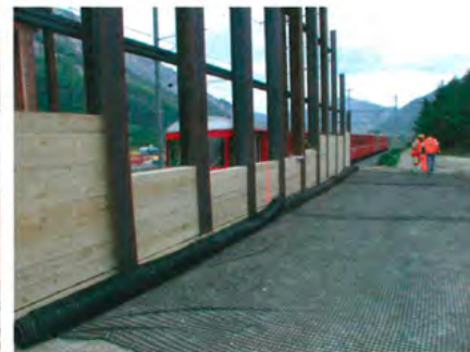
10 Bewehrtes Widerlager mit Vorbelastung bei Venlo, Niederlande © Huesker Synthetic GmbH
