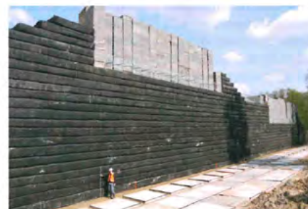
10 Bewehrtes Widerlager mit Vorbelastung bei Venlo, Niederlande © Huesker Synthetic GmbH
