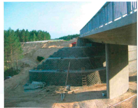
3 Brücke an der Via Baltica in Lettland © Huesker Synthetic GmbH
