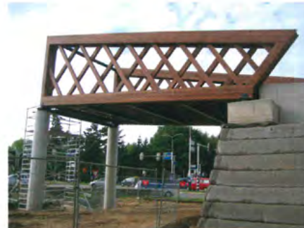
9 Bauwerk an der N 302 bei Harderwijk, Niederlande © Huesker Synthetic GmbH
