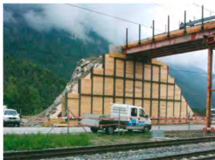
11 12 KBE als geogitterrückverankerte Trägerbohlenwand bei Domat-Ems, Schweiz © Huesker Synthetic GmbH
