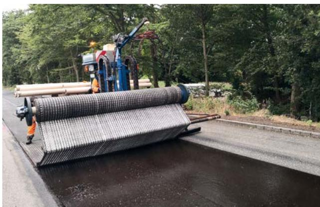
Laisser 5 à 10 cm par rapport au bord de la route. Au niveau des plaques d'égouts, le composite SamiGrid sera découpé avec un simple cutter.
