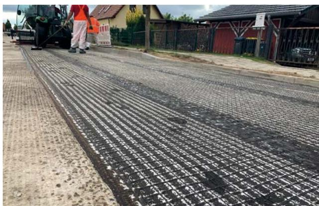
Si on se place dans le sens de marche du finisseur, le bout d'un lé doit toujours recouvrir le début du lé suivant pour empêcher que celui-ci ne soit soulevé par le finisseur. Si on a plusieurs lés juxtaposés ou consécutifs, les chevauchements doivent être décalés de manière à éviter tout chevauchement multiple.
