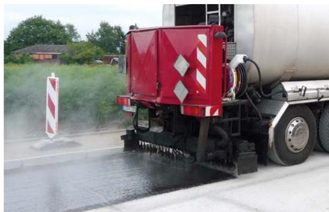
Le support ainsi préparé devra recevoir une couche d'accrochage homogène avec  $1,8 \text{ kg/m}^2$  d'une émulsion bitumineuse élastomère avec une teneur en bitume de 70%. En cas de couches support rugueuses et à pores ouverts, la quantité minimale d'émulsion devra être augmentée. Lors du fraisage de la couche support, une quantité de  $2,3 \text{ kg/m}^2$  peut être nécessaire.
