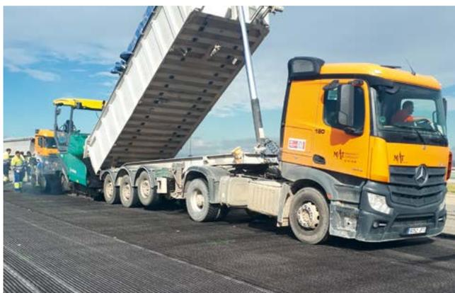
L'épaisseur de la première couche d'enrobé doit être de 4 cm au moins à l'état compacté. Les raccords des couches d'enrobés ne doivent pas coïncider avec les recouvrements des lés du composite.
