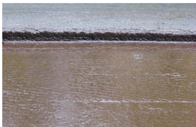
L'émulsion doit être pulvérisée à l'aide d'un pulvérisateur à rampe de manière à garantir une répartition homogène du liant. Dans les zones à rayon réduit ou les embranchements, la pulvérisation peut avoir lieu avec une lance manuelle.
