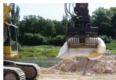
Installation à l'aide d'une excavatrice ou similaire
