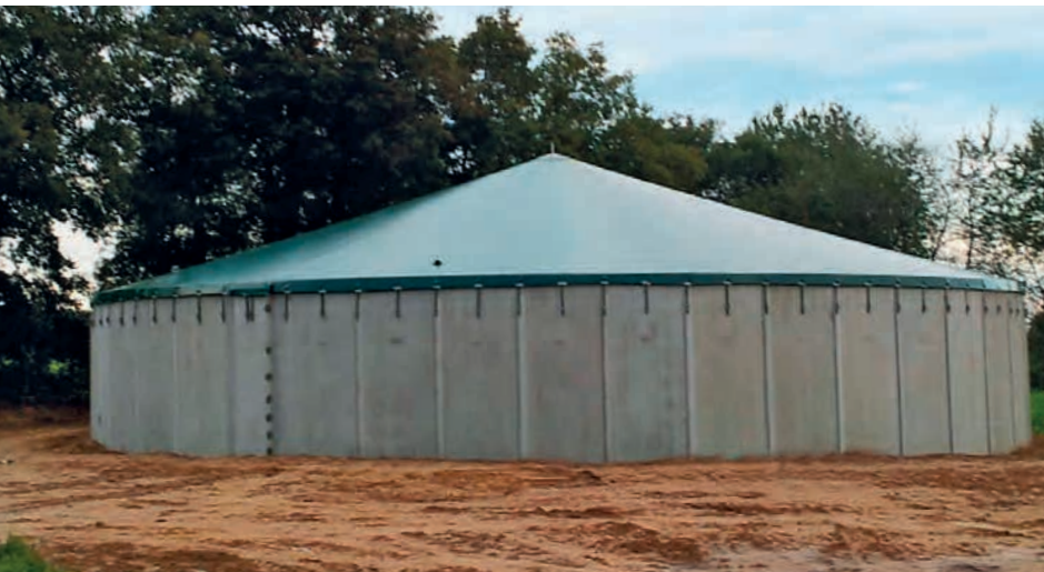
Couverture sur réservoir en éléments préfabriqués (MST 1A 6/44), Damme en Allemagne
