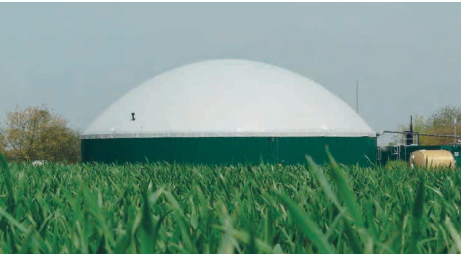
Toit à double-membrane sur réservoir en béton, Grefrath en Allemagne
