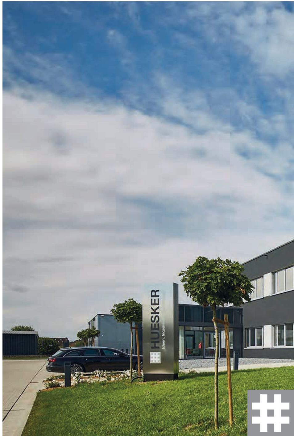
Vue extérieure du bâtiment des bureaux à Dülmen
