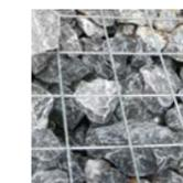
Remplissage avec des pierres résistantes au gel et à la compression
