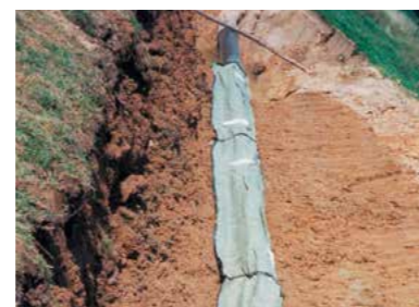
2006 Lestage par couverture, France, gazoduc
