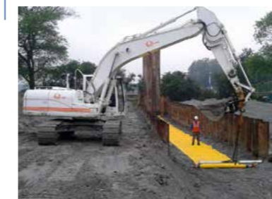
2013 Avertissement et protection, France, chantier Loon-Plage, gazoduc
