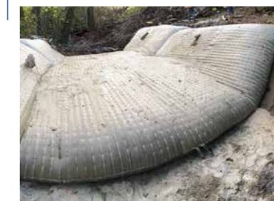
2015 Protection contre l'érosion, France, gazoduc
