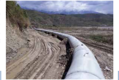
2017 Enrobage de protection et lestage, Grèce, Albanie, TAP, gazoduc
