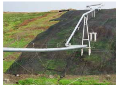
2004 Renforcement de talus, Russie, Bakou-Novorossiisk, oléoduc
