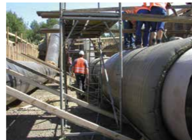
2009 Enrobage de protection et lestage, Allemagne, Essen, gazoduc
