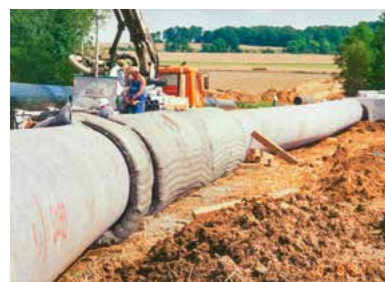
1997 Enrobage de protection et lestage, France, rivière de la Luce, gazoduc
