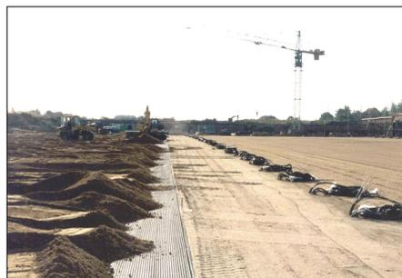
Einbau der 2. Geogitterlage (Längsbewehrung),
