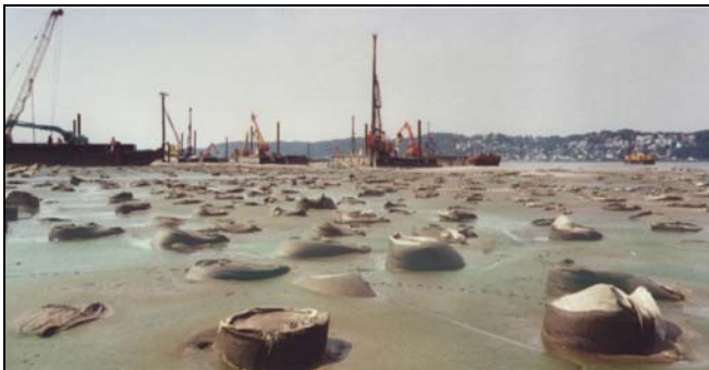
Figura 12: vista sui pali in sabbia incapsulati
