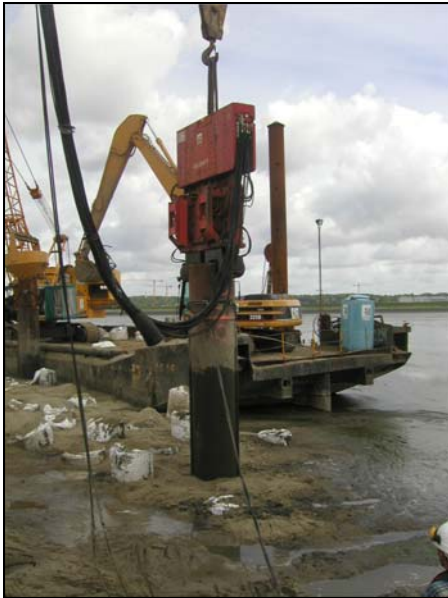
Figura 11: infissione della camicia in acciaio
