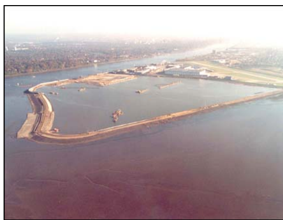
Figura 10: vista aerea della zona bonificata
