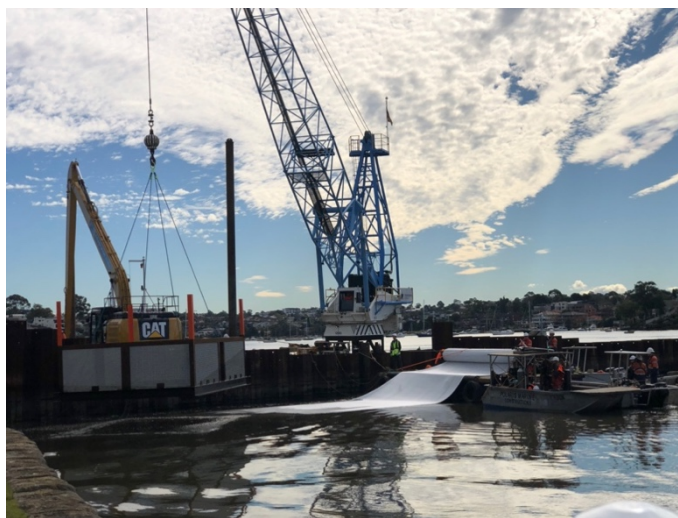
Figura 7. Posa del geocomposito attivo.
