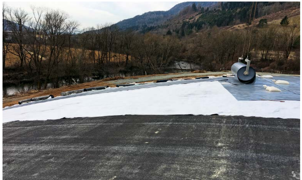
Abbildung 2: Installation der Oberflächenabdeckung. Im Vordergrund in schwarz liegt die 11 \text{ kg/m}^2 Calciumbentonitmatten NaBento RL-C, in weiß dahinter die 2 \text{ kg/m}^2 Aktivkohlematte Tektoseal Active AC, in grau und auch auf der Rolle befindend sich die PE-LD Membran mit integrierter CKW-dichter Aluminiumschicht.
