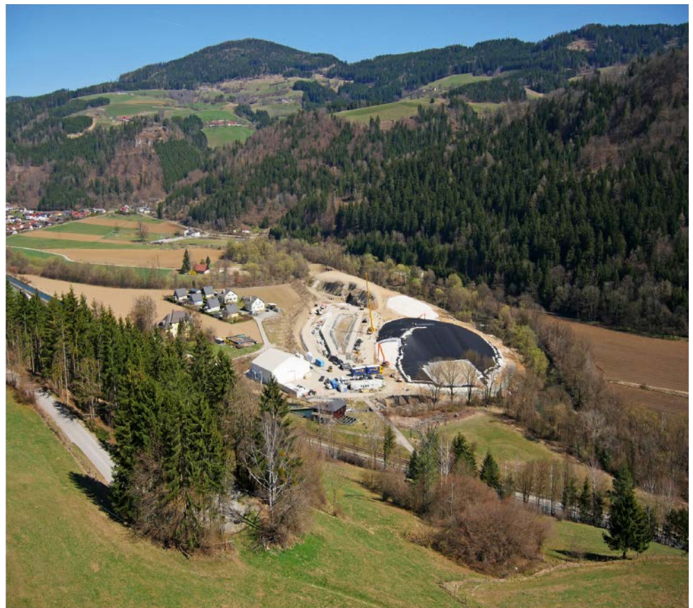
Abbildung 1: Altlast K20 – im vorderen Teil des Bildes befindet sich Teil I, der bereits größtenteils mit der Oberflächenabdichtung bedeckt ist. Dahinter befindet sich Teil II. (Stand: 28.3.2017)
