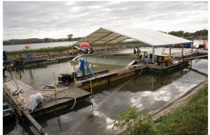
**Bild 5** Pontongestütztes Einbauverfahren mit Installation und Betonage des Sohnelements
