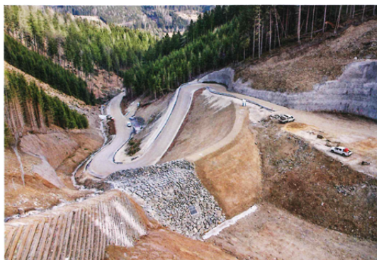
Bild 4. Geokunststoffbewehrte Steilböschung mit Blick ins Tal
