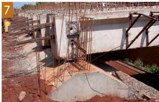
Figuras 6 e 7 – Vista dos viadutos e detalhe do apoio sobre o muro em solo reforçado
