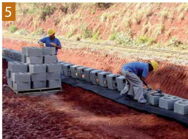
Figuras 4 e 5 – Detalhes da colocação da geogrelha e dos blocos
