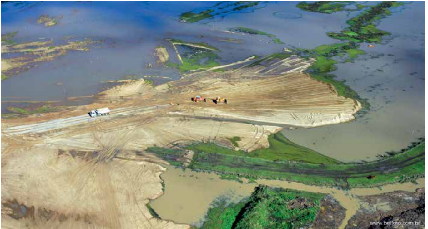
Rodovia do Parque: aterros sobre solos moles (Fonte: internet http://www.br448rodoviadoparque.com.br/rodovia/index.html )
