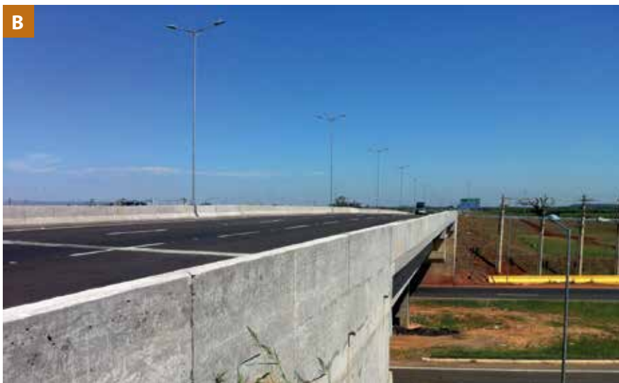
Figura 3 – Viaduto sobre a BR 116: a) Execução de uma coluna encamisada; b) Obra finalizada
