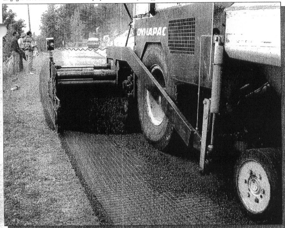
La griglia deve essere aderente alla superficie durante il passaggio della finitrice.
