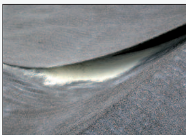
Figura 5 - Un esempio di sormonto realizzato con bentonite in polvere
