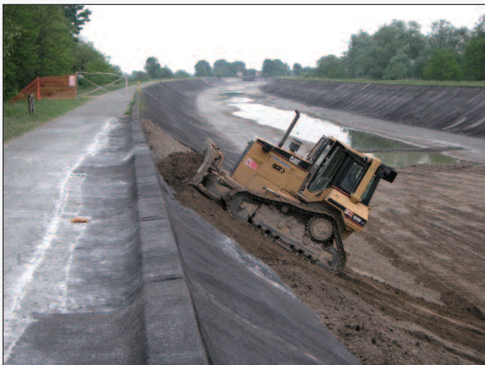
Figura 8 - Il geocomposito bentonitico deve resistere alle sollecitazioni di taglio anche nella fase di ricoprimento con il terreno
