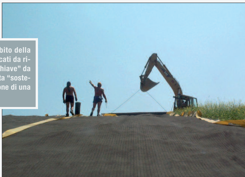
Figura 1 - La posa del NaBento® per la realizzazione del "capping" di una discarica
