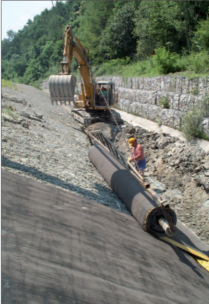
Figura 7 - La posa del NaBento® RL-C con una pendenza rilevante
