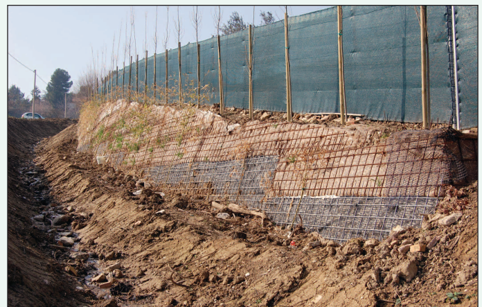
Figura 10: Vista della terra rinforzata a lavori ultimati
