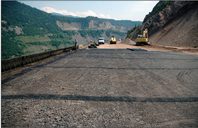
Figura 6 - Le fasi di posa della terra rinforzata
