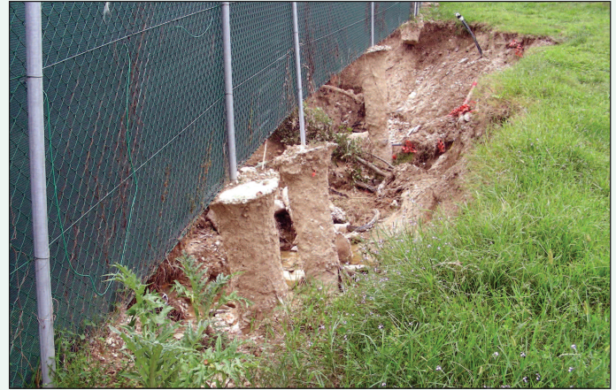
Figura 8 - I fenomeni erosivi causati dalle piene dei corsi d'acqua
